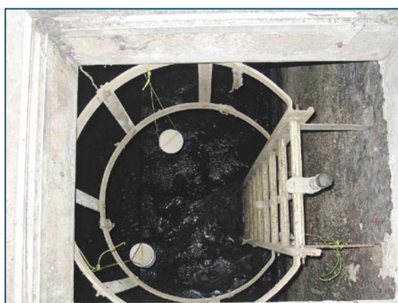
Rys. 1. Studzienka kanalizacyjna. Jedno z najciekawszych zastosowań sublimujących żeli w puszkach. Są bardzo wygodne w stosowaniu w małych pomieszczeniach
