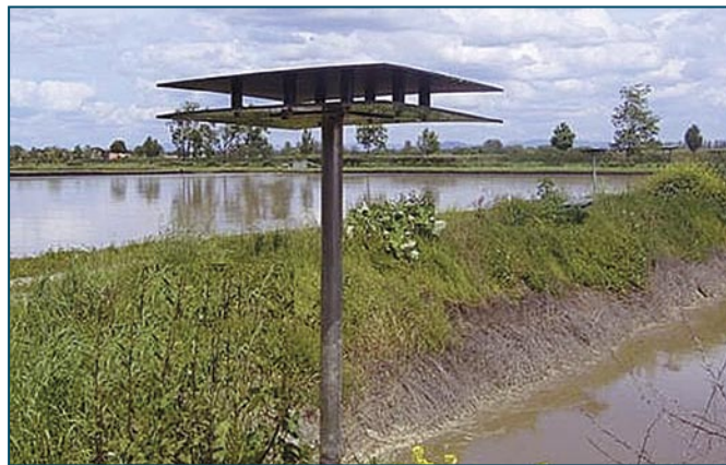
Rys. 3. Płytki IDRAGEL w statywach emisyjnych. Wygodne rozwiązanie dla lagun ściekowych i poletek osadowych. Szczególnie przy okresowym pojawianiu się odorów
