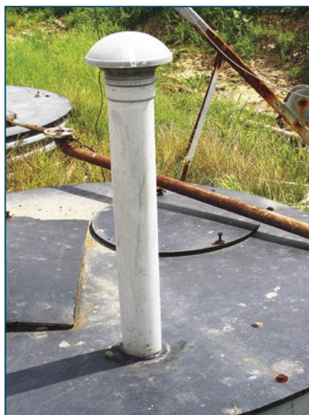
Rys. 2. Neutralizacja zapachu w kominkach wentylacyjnych studzienek kanalizacyjnych
