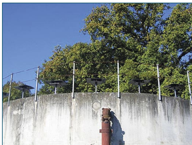
Rys. 3. Płytki IDRAGEL w statywach emisyjnych. Wygodne rozwiązanie dla lagun ściekowych i poletek osadowych. Szczególnie przy okresowym pojawianiu się odorów
