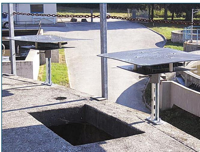
Rys. 4. Płytki IDRAGEL tworzą barierę antyodorową na krawędzi kolektora ścieków
