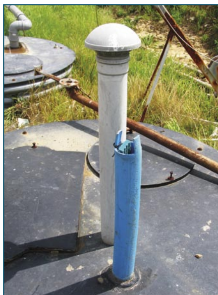
Rys. 2. Neutralizacja zapachu w kominkach wentylacyjnych studzienek kanalizacyjnych
