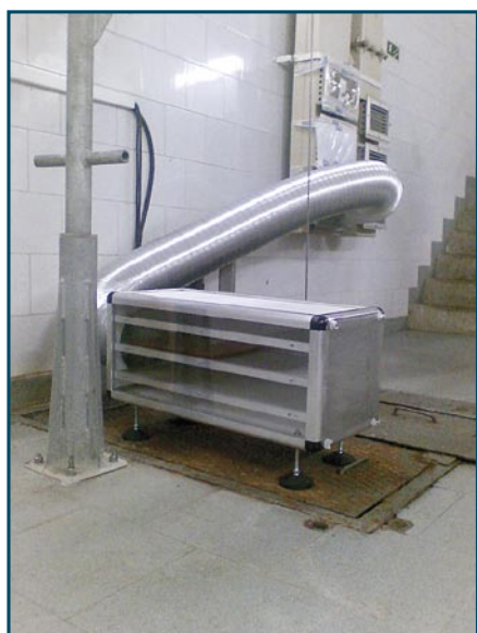
Rys. 5. Dezodoryzacja w przepompowni ścieków: skrzynka z solubilizującymi żelami
