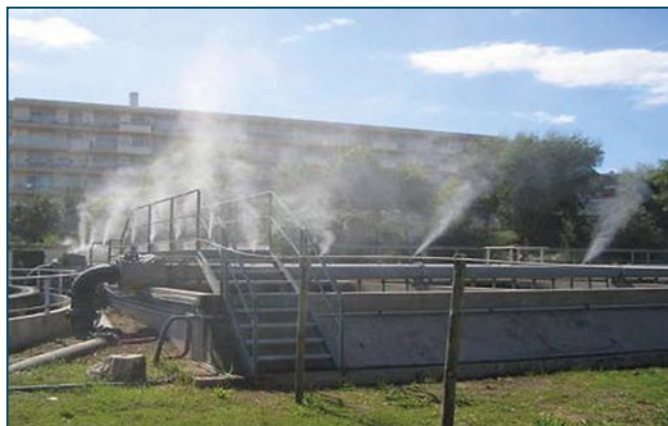
Rys. 2. Bariera antyodorowa nad aertorem ścieków
